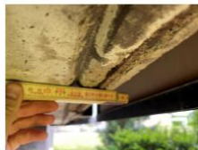
Foto 3: Gjutskarv med rostfärgad avlagring.
